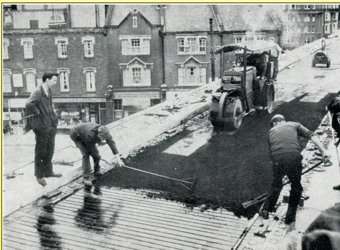
1969 Укладка асфальта на верхнюю проезжую часть развязки Хаммершмидта в Лондоне (Электрический обогрев проезжей части, Роберт Феликс, 1971 г., Музей Ultimheat\*)
